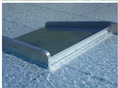
Verbindungsutsche zwischen den beiden Niveaus
